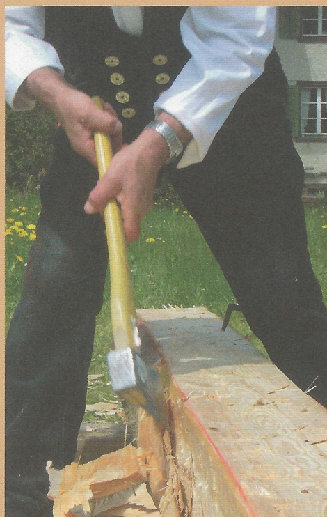
Balken hauen. Wie geschickte Zimmerleute früher Balken mit dem Zimmermannsbeil behauen haben, sah man am Mülitag 2008.
