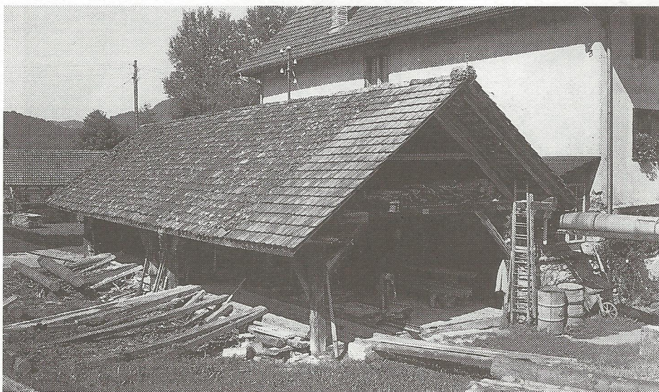
Der Sägereianbau. Rechts das Rohr, das dem Wasserrad unter dem Pultdach das Oberwasser zuführt.
