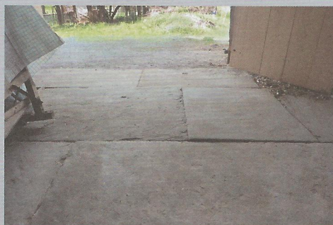
Der Scheunenboden aus Sandsteinplatten soll erhalten bleiben
