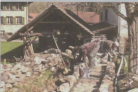
Chrigel Zwicky erstellt den Natursteinkanal bis zum Anschluss an den Chännel
