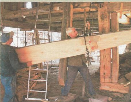
Die speziell angefertigte Stütze wird montiert.
