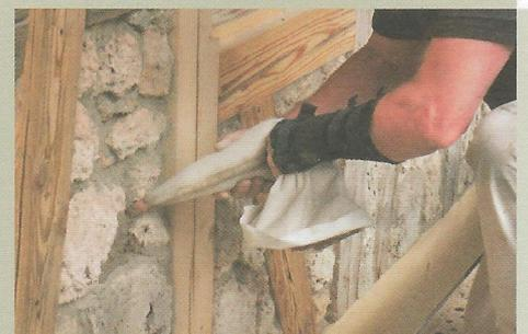
Die Ausfachtung der Riegelfelder mit einem «Spritzsack».
