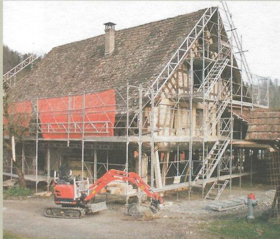
Die Ostfassade kurz vor dem Anheben. Das schräge Vordach ist bereits zurückgebaut worden.
