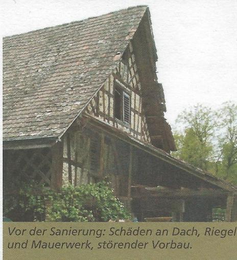
Vor der Sanierung: Schäden an Dach, Riegel und Mauerwerk, störender Vorbau.
