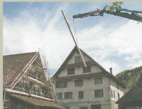
Der 350 kg schwere und 9,6 m lange Kehlbalcken wird eingefahren.
