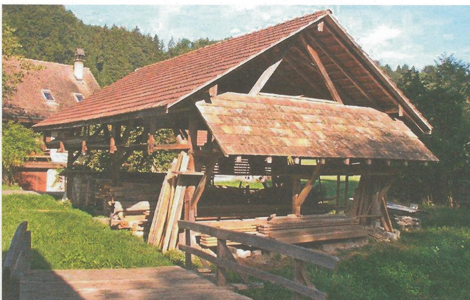
Das instandgestellte Vordach des Bretterschopfes auf der Seite des Unterkanals
